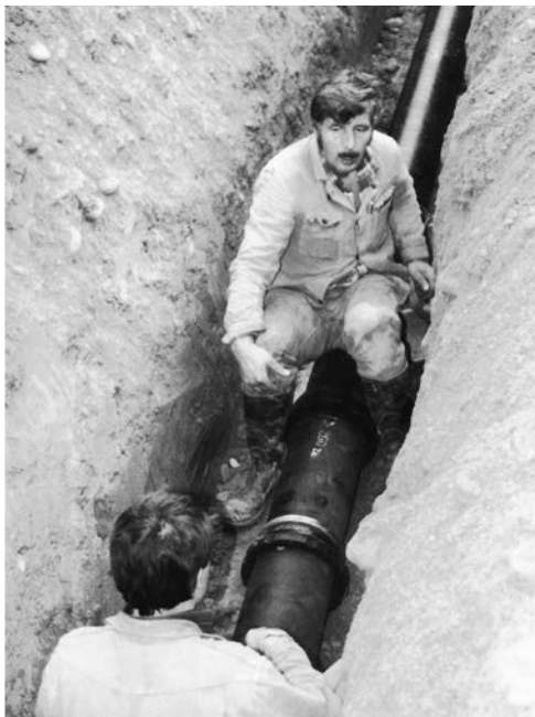
Bau einer Wasserleitung, NW 300 mm Ø, duktiler Guss
