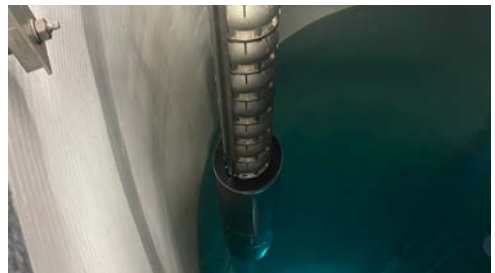
Ersatz der Unterwassertauchpumpe 3 im 2021
