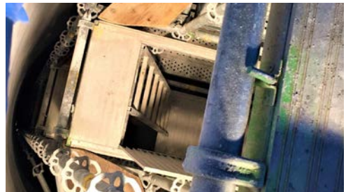
Der Brunnenschacht während der Bauphase, 2015
