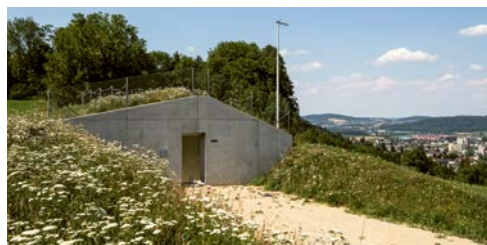
Das neue Quellwasserpumpwerk Möösli, 2014
