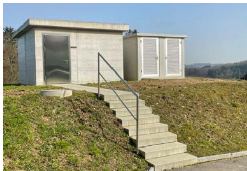
Neubau als Ersatz des bestehenden Reservoirs Sandbüel 2017, inkl. neuer Trafostation, 2020
