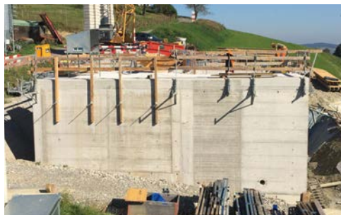
Neubau Reservoir Sandbüel – Die Bauarbeiten, 2015/16
