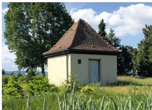
Grundwasserpumpwerk Unterzelg vor der Sanierung, 2016
