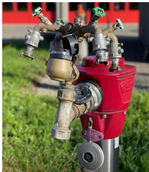
Temporärer Bauwasseranschluss
