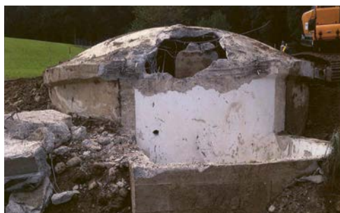
Freilegung, altes Reservoir/Pumpwerk Möösli, 1904–2012
