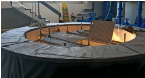
Der Brunnenschacht wurde während der Bauphase 2015, speziell abgedeckt
