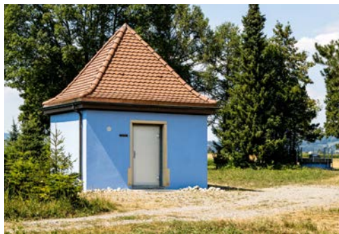
Grundwasserpumpwerk Unterzegg erstrahlt in neuem Glanz
