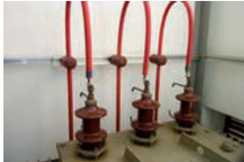
Anschlussdetail ältere Trafostation
