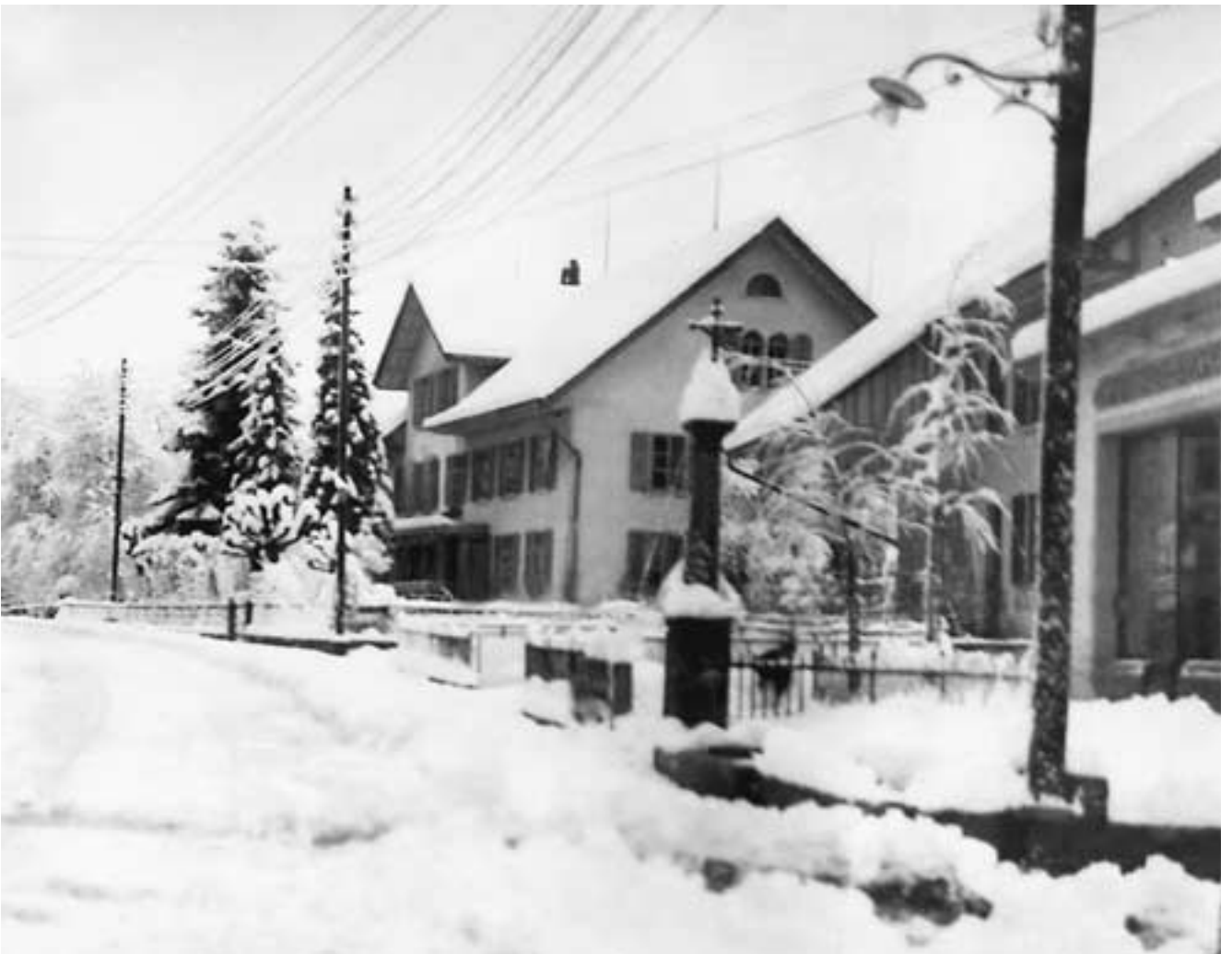
Durch Witterungseinflüsse wie Schnee, Sturm und Gewitter entstanden bis vor 40 Jahren relativ häufig Stromunterbrüche. Heute ist das Verteilernetz zu über 95% verkabelt
