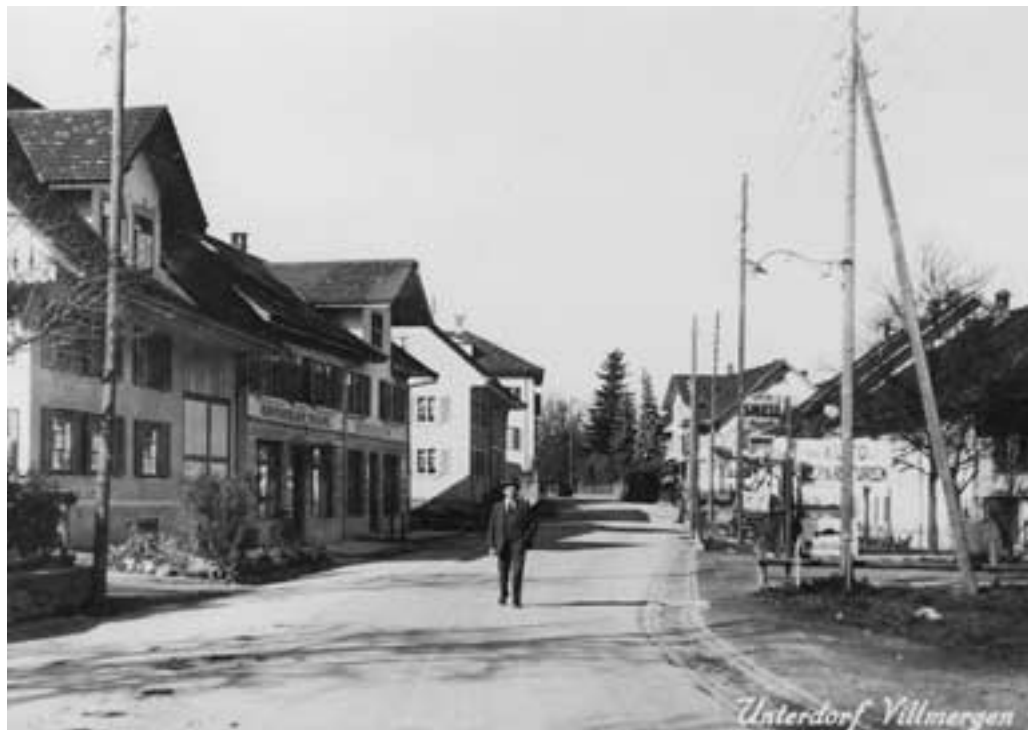
Telefon- und elektrische Freileitungen sowie Dachständer-Hausanschlüsse und verzierte Strassenlampenausleger prägten in früheren Jahren das Dorfbild
