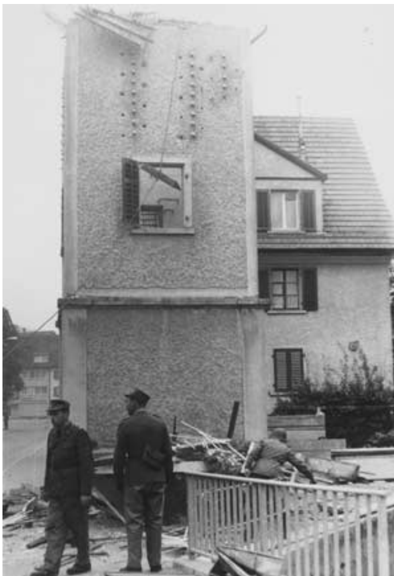
Die erste Trafostation an der Bahnhofstrasse erstellt 1902 wurde 1968 abgebrochen
