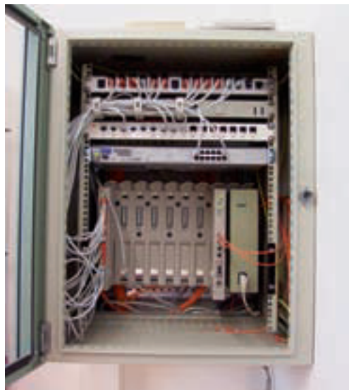
EDV-Etagenverteiler
