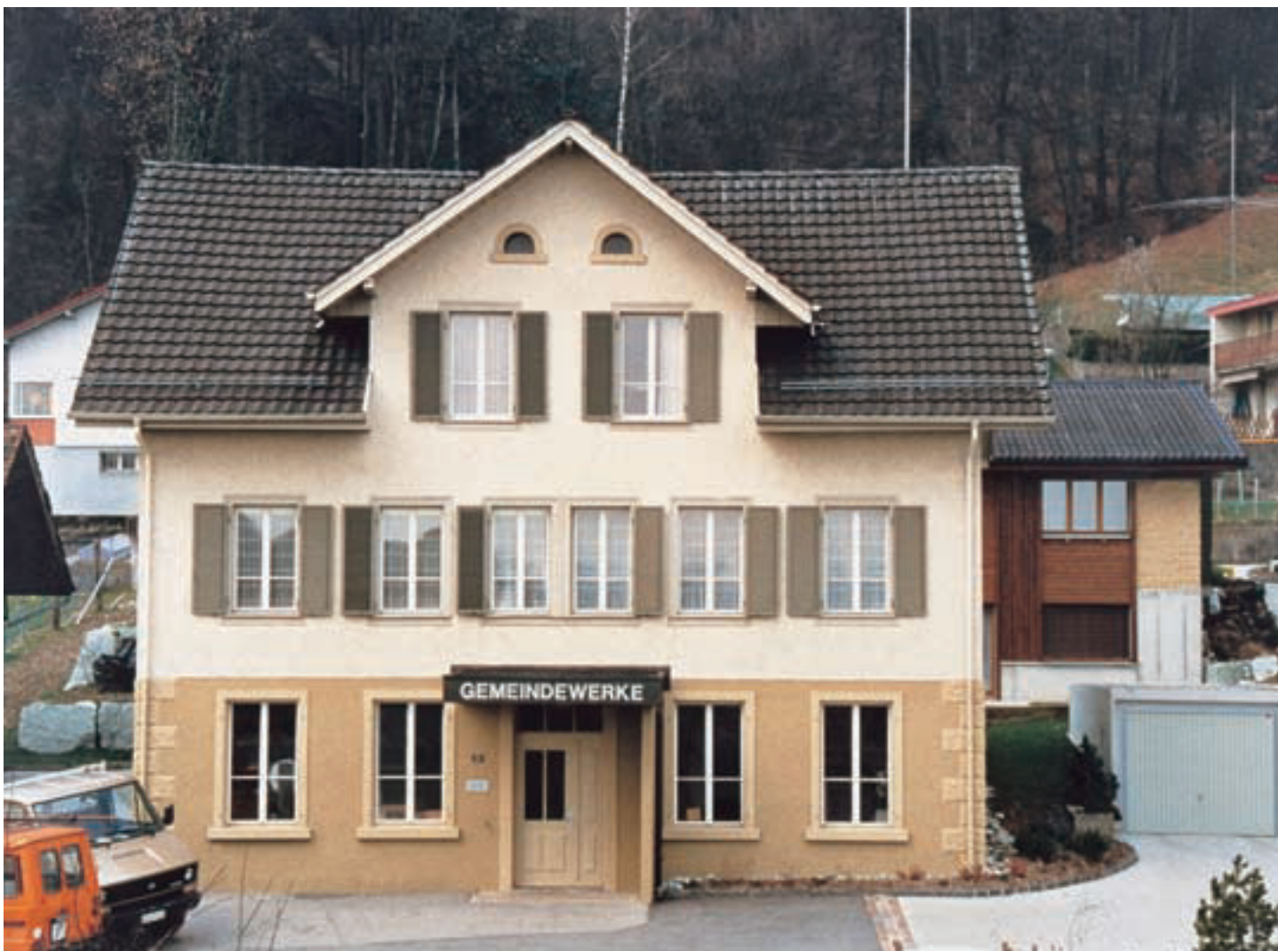
Gebäude Kirchgasse 24 «Remigihaus» diente der Elektra und später den Gemeindewerken während rund 70 Jahren als Magazin und Bürogebäude
