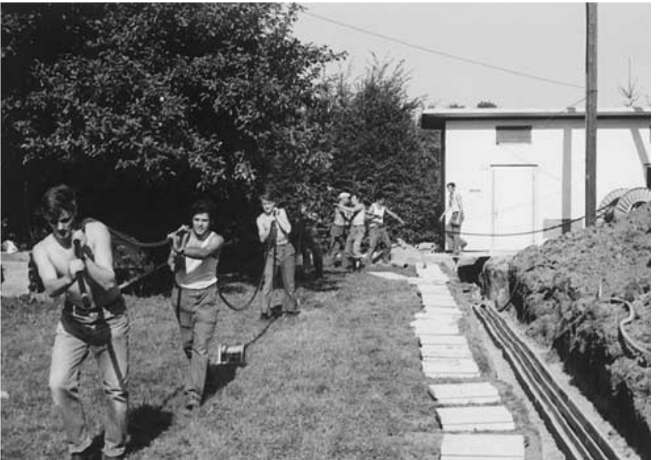
Kabelzug von Hand ohne Zugmaschine um 1970
