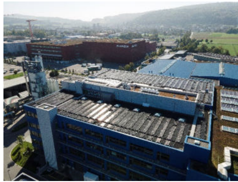
PV-Anlage GELOG II
