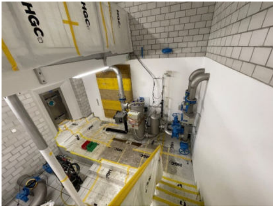
Reservoir Bergmättli Umbau UV- und Trübungsanlage
