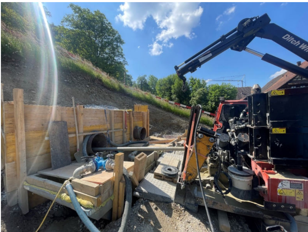
Startgrube Grabenloser Leitungsbau, Geislerain
