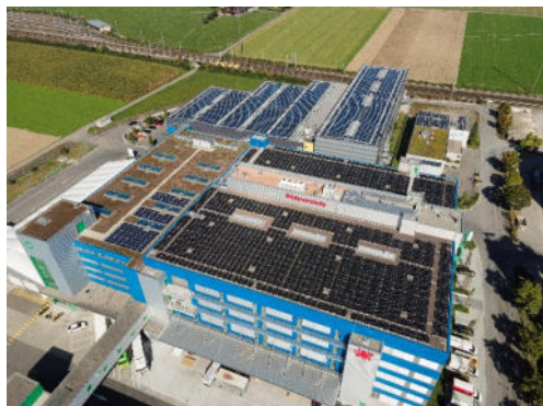
PV-Anlage GELOG II
