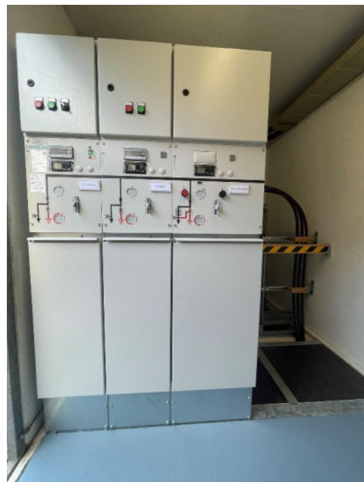
Mittelspannungsanlage nachher
