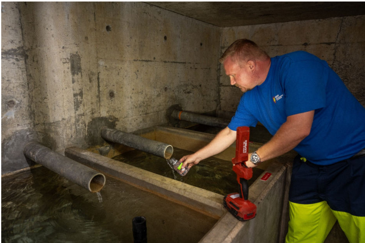
Unterhalt/Wasserproben Brunnstube Grossmoos - Sven Tauchert, Brunnenmeister WV
