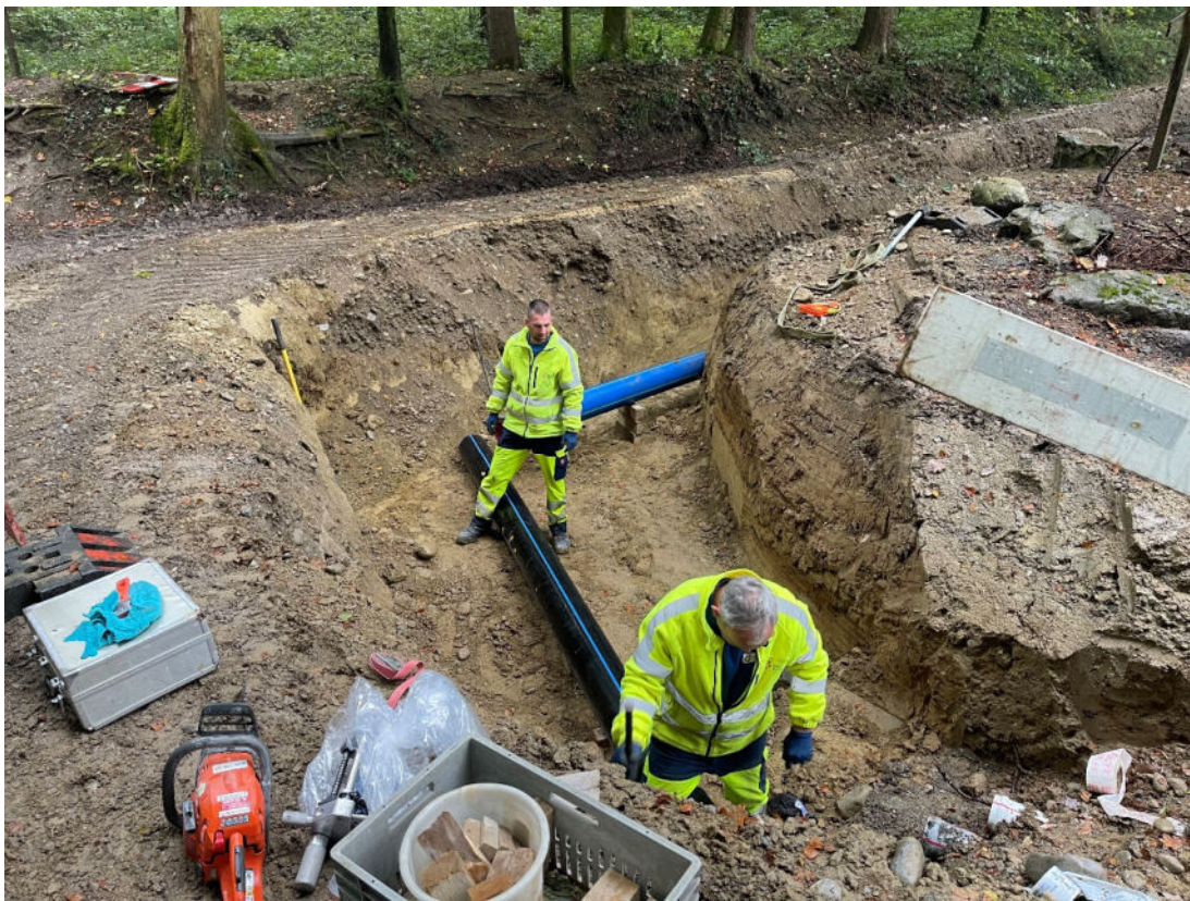
Werkleitungsbau Reservoir Bergmättli - Marino Jappert, Rohrnetzmonteur WV und Mario Schaad, Rohrnetzmonteur WV
