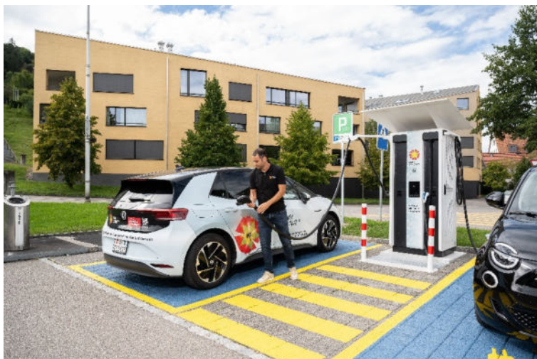
Schnellladestation Dorfplatz – Andrea Del Sole, Leiter Elektroinstallationen EI
