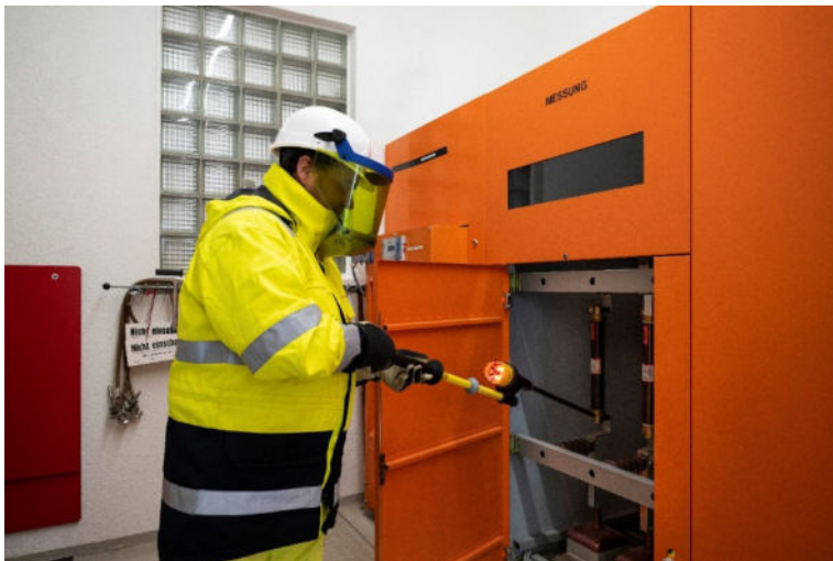
Unterhalt Trafostationen - Mario Caduff, Netzelektriker EV
