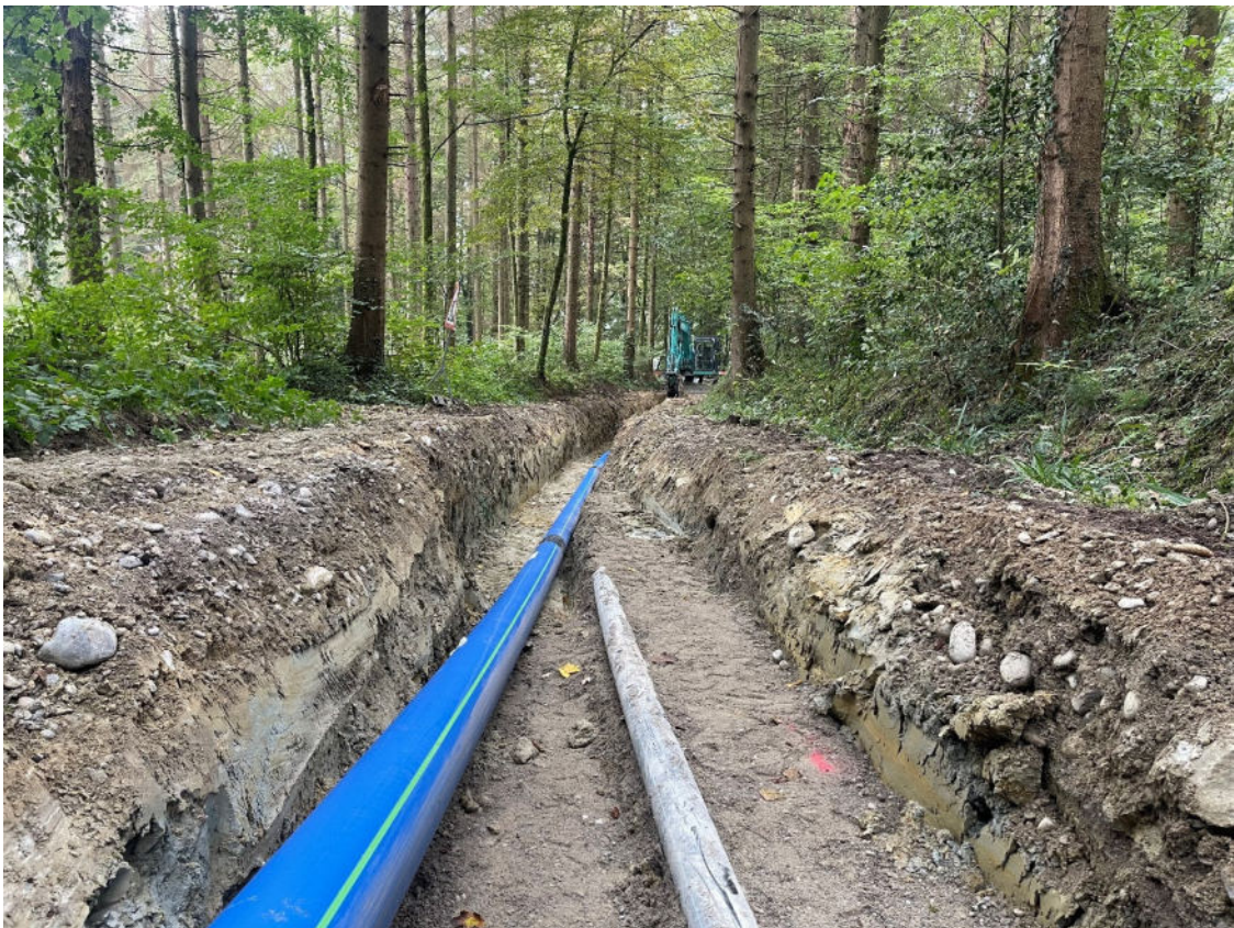
Erweiterung der Quellableitung
