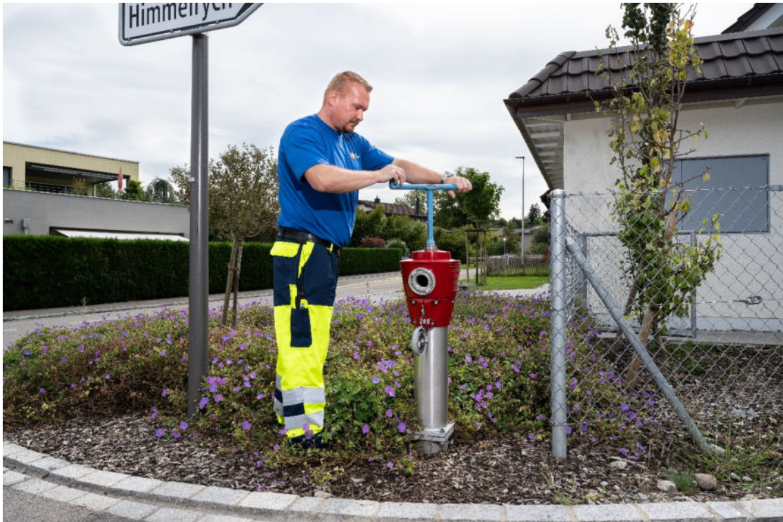
Hydrantenkontrolle Himmelrych - Sven Tauchert, Brunnenmeister WV
