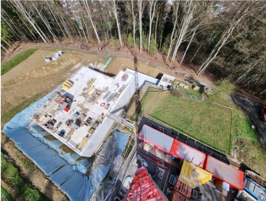
Reservoir Bergmättli Erweiterungsbaustelle
