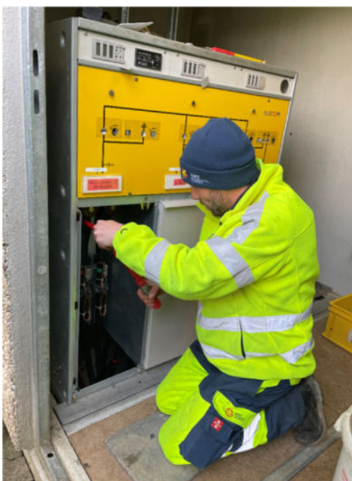
Kabelanschluss an Mittelspannungsanlage – Benjamin Lütolf, Leitender Netzelektriker EV
